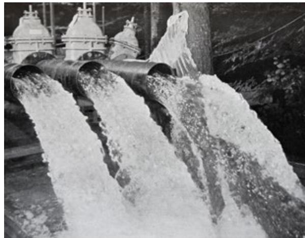
*Pumpversuch mit 28000 Minutenlitern Wasserentnahme aus dem Grundwasserstrom, Oktober 1958. Bildnachweis: Hauri LNB 1962: S. 61.*
