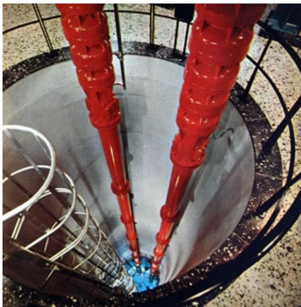
*Blick in den 35 Meter tiefen Brunnenschacht von 3 Metern Durchmesser. Die damals installierten zwei Pumpen wurden 1972 durch eine dritte Pumpe mit 12000 Minutenlitern Förderleistung ergänzt. Bildnachweis: Hauri LNB 1962: S. 62.*
