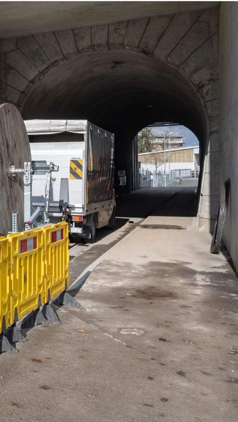
Anschliessend begann das Einziehen der sogenannten Stammkabel. Sie bündeln in der Regel über 400 Glasfasern. Die Stammkabel verlaufen von den POP aus über lange Strecken in die Quartiere. Bei den Muffen im Netz zweigen die Glasfaserkabel in Richtung der Hausanschlüsse ab.
